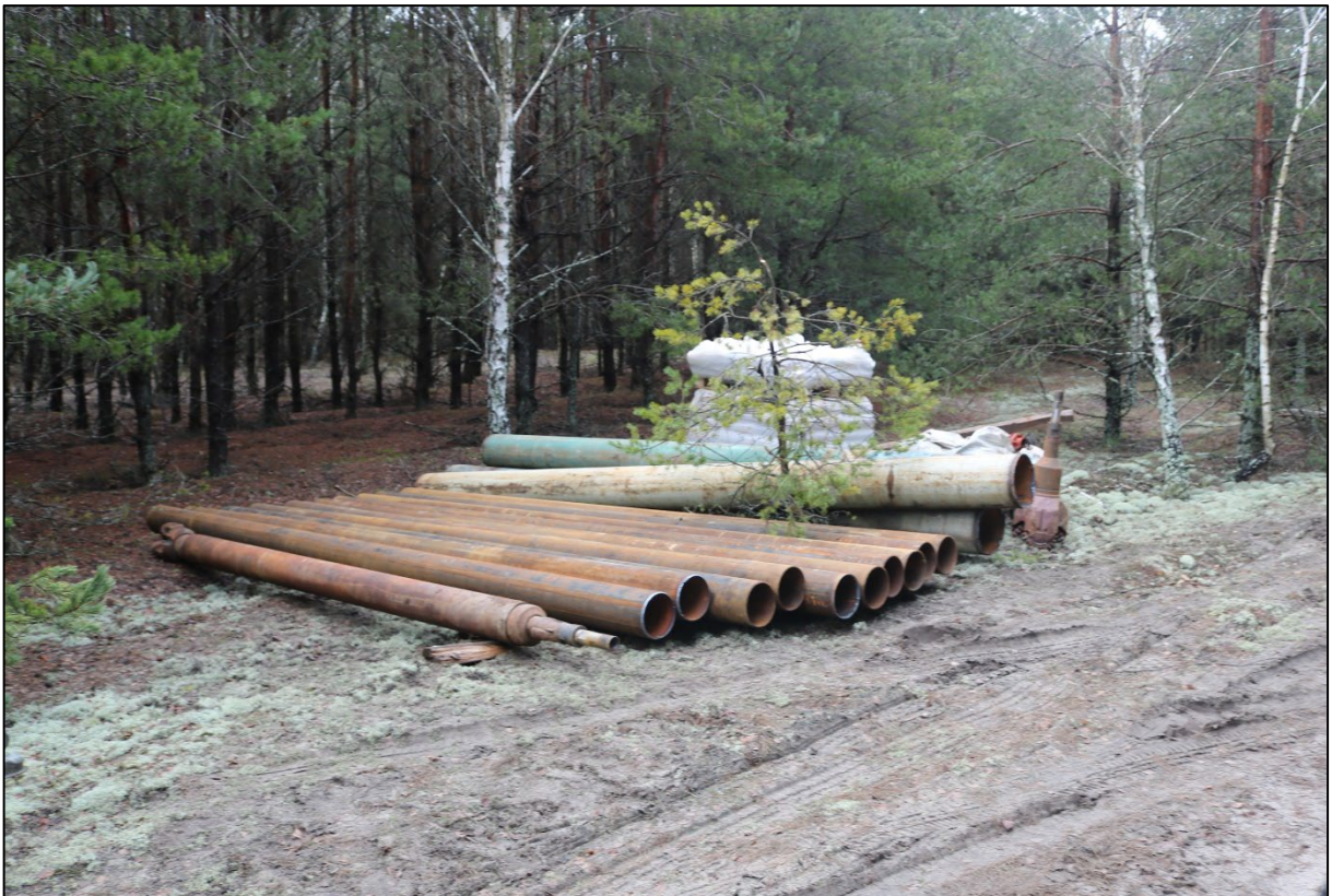
Рисунок 1.5 — Участок строительства водозаборных скважин
